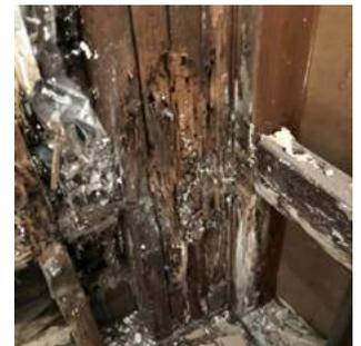
Le mэрule se nourrit des matériaux présents dans la maison, principalement de la cellulose du bois. Cependant, il a été découvert que ce champignon a également besoin de calcium et de fer pour se développer. Ainsi, il peut s'attaquer aux plâtres, aux briques et aux métaux pour récupérer les nutriments nécessaires à sa croissance. Le mэрule apparaît souvent dans des endroits sombres, préférant les bois dont l'humidité se situe entre 30 et 40 %.
